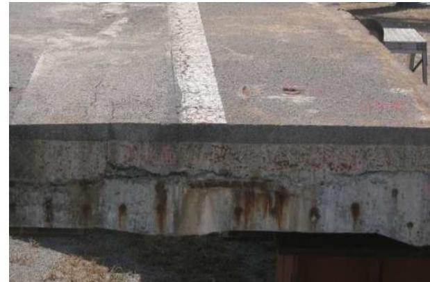
図 コンクリート床版中の水平ひび割れ
